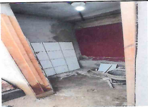
FOTO: NO 4 PISO Y AZULEJO BAÑOS
