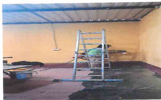
FOTO NO. 3 PINTURA GENERAL ESCUELA
