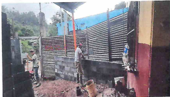
FOTO NO. 2 REMOCION MURO
