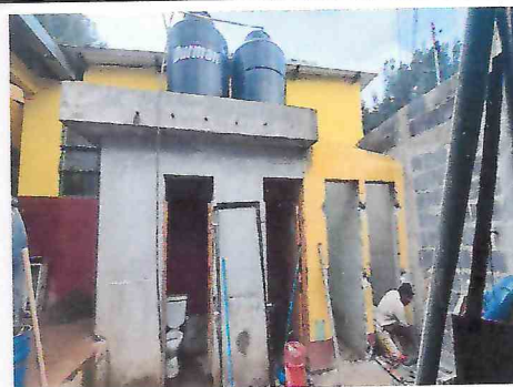
FOTO NO 5 PUERTA DE BAÑOS
